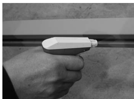
Besprühen der Profilnute mit Seifenwasser
